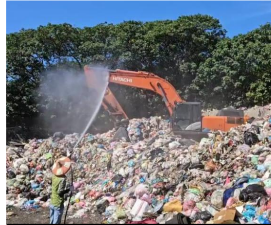
直接噴灑臭源進行除臭
